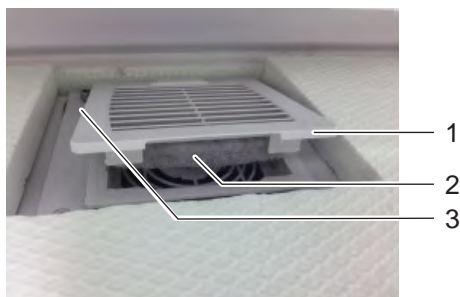
kuva 5-15 Ylemmän suodatinkankaan vaihtaminen
